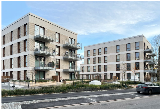
Täydennysrakentamista 1960–70-lukujen asuinalueelle: As Oy Lehtisaaren Terassi, Helsinki; suunnitellut Schauman & Nordgren Architects. Selkeä julkisivun sommittelu ja kerrostasojen korostaminen tukevat pelkistettyä ja hillittyä yleisilmettä.
