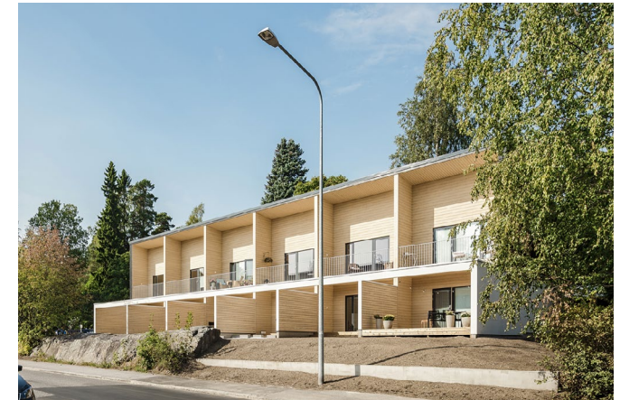
Täydennysrakentamista 1970-luvun asuinalueelle: Humalniementie 12, Laajasalo, Helsinki; suunnitellut INARO Oy. Yksinkertainen ja yksiaineinen julkisivu sopii hyvin ympäristöönsä. Rivitalon asunot jakokeskustelee betonielementtitalojen rytmin kanssa.
